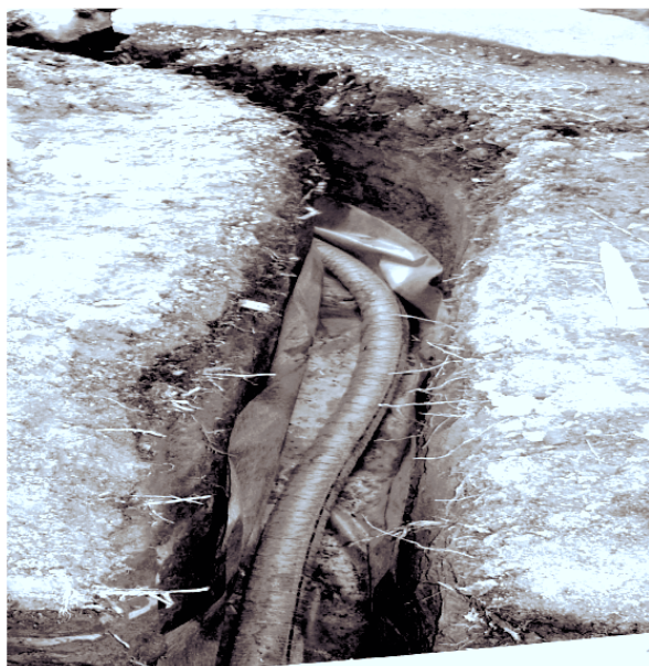
Рис. 6. Технология укладки дрены вблизи деревьев.
