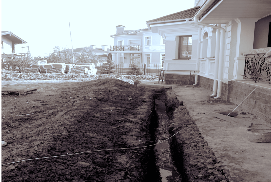
Рис. 5. Строительство дренажной системы, совмещенной с ливневой канализацией
