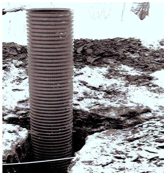
Рис. 7. Строительство ревизионного колодца в зимний период.
